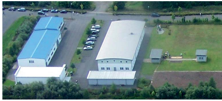
EBINGER Technikzentrum Wiesbaum
